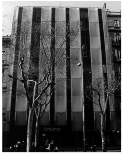
Estado inicial / Initial state
