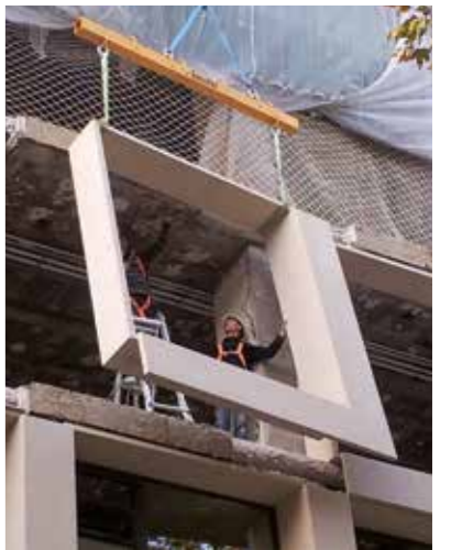
En construcción / Under construction
