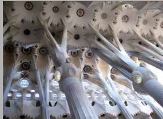
← Nave de la Basílica de la Sagrada Família, Barcelona. Estructura arborescente en hormigón prefabricado.
