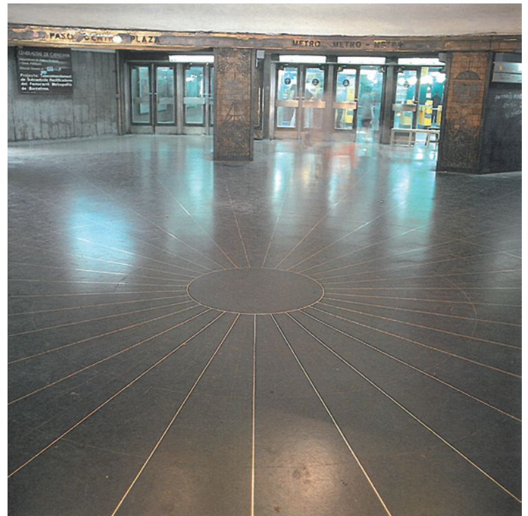
PAVIMENTO DE INTERIOR VIBROPRENSADO, ESTACIÓN METRO PLAZA CATALUÑA.
