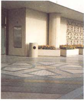
Pavimento de vibrado relieve bicolor. H.O.K. (E.U.U.). Aeropuerto internacional Rey Jaled. Riad. 1981-82
