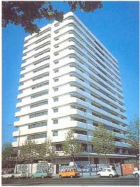
Fachada de hormigón arquitectónico. Ignacio Ferrer. Edificio Los Guindos. Madrid. 1977-1979 Construction concrete façade. Ignacio Ferrer. Los Guindos Building. Madrid. 1977-1979
