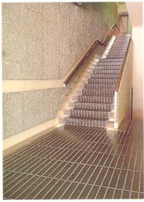
Pavimento de vibrazo relieve basáltico y peldaños. Equipo técnico y J. A. Coderch. Edificio Trade. Barcelona. 1966-1969 Basalt relief "vibrazo" paving and steps. Technical development team and J. A. Coderch, Trade Building, Barcelona. 1966-1969
