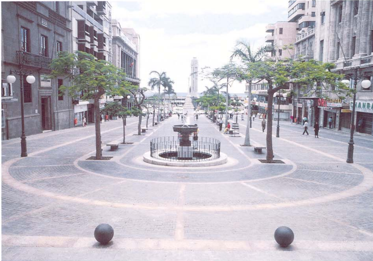
Pavimento de adoquines basálticos. Equipo técnico, Francisco Artengo y Pedro Domínguez. Plaza Candelaria. Santa Cruz de Tenerife. 1986 Basalt cobblestone paving. Technical development team, Francisco Artengo and Pedro Domínguez. Plaza Candelaria. Santa Cruz de Tenerife. 1986
