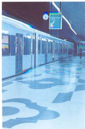
Pavimento de vibrazo unicolor. Equipo técnico. Estación de metro. Línea 9. Duque de Pastrana. Madrid. 1978 One-tone "vibrazo" paving. Technical development team. Metro station Duque de Pastrana. Line 9, Madrid. 1978
