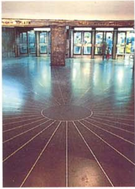
Pavimento de vibrazo basáltico con tira de latón. Equipo técnico y Josep M. Fargas. Rotonda Metro. Plaza de Cataluña. Barcelona. 1970 Basalt "vibrazo" paving with brass strip. Technical development team and Josep M. Fargas. Metro rotunda. Plaza de Cataluña. Barcelona. 1970
