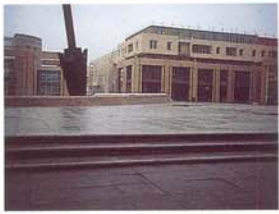
Pavimento, gradas y mobiliario urbano. Equipo técnico. Place de la Liberté. Blanc Mesnil (Ile de France). 1994 Paving, stairs and urban furniture. Technical development team. Place de la Liberté. Blanc Mesnil (Ile de France). 1994
