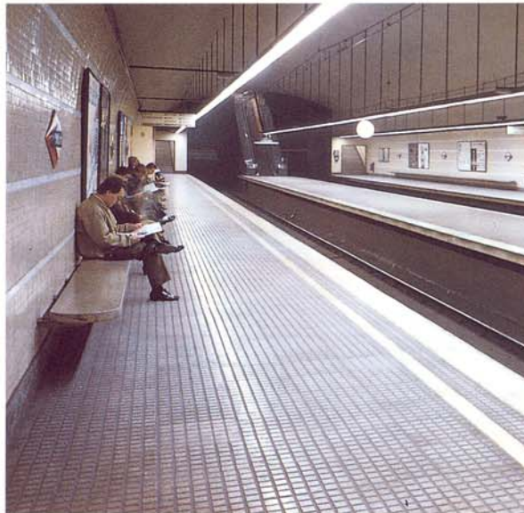
Pavimento y peldaños de vibrado relieve. Equipo técnico, J. Bach y C. Mora. Ferrocarriles Catalanes. Estación Bonanova. Barcelona. 1982 "Vibrado" relief paving and stairs. Technical development team, J. Bach and G. Mora. Catalan Railways. Bonanova station. Barcelona. 1982
