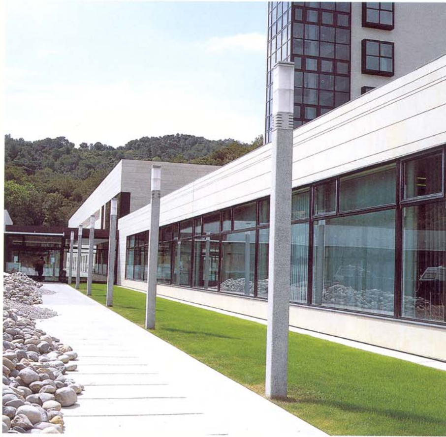
Luminaria Prisma. Ramon Forcada. Hospital Provincial de Blanes. 1990 Lighting: Prisma. Ramon Forcada. Blanes Provincial Hospital. 1990
