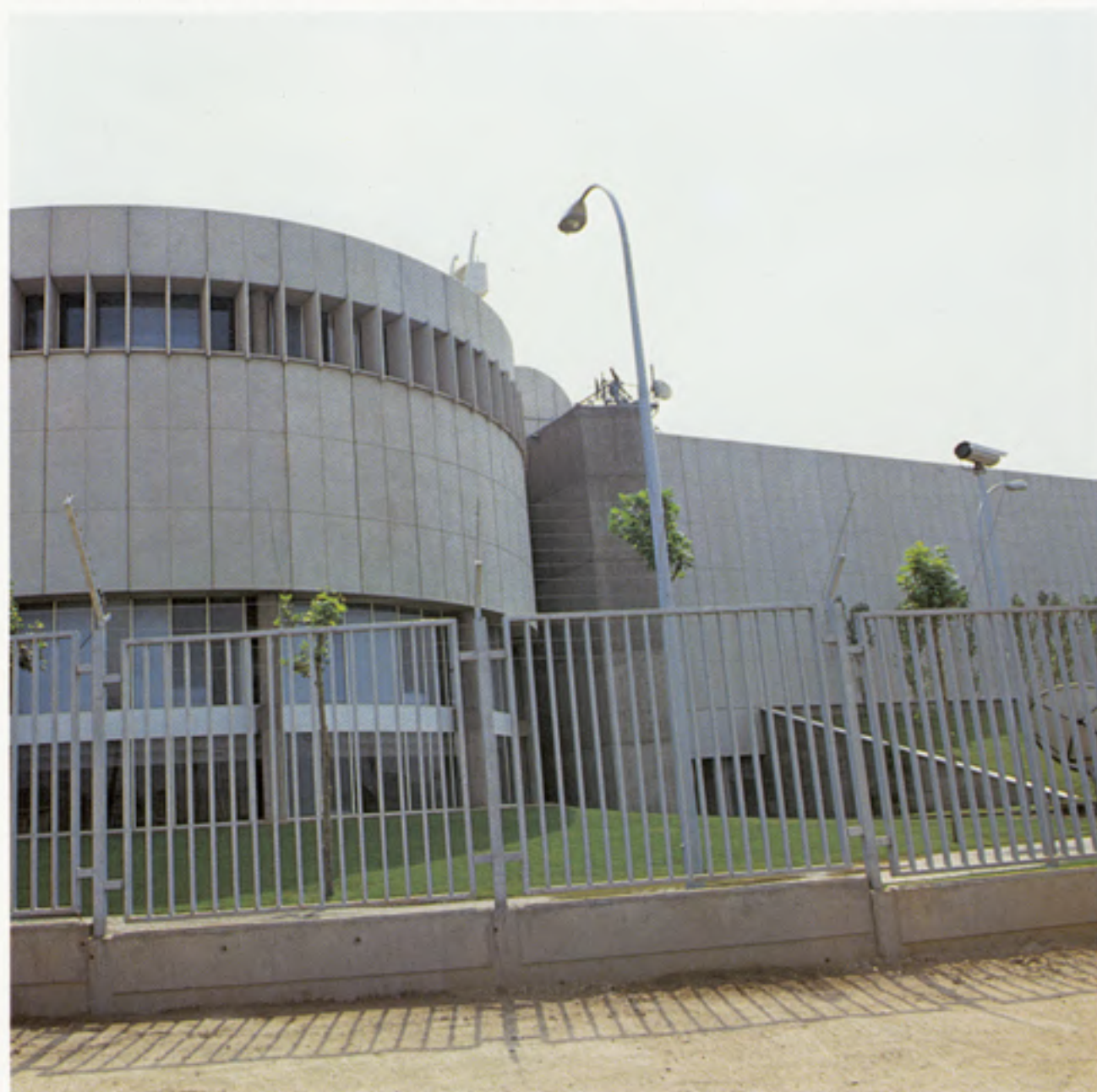
Cerramiento en grandes paneles prefabricados para TV-3. St. Just Desvern (Barcelona).
