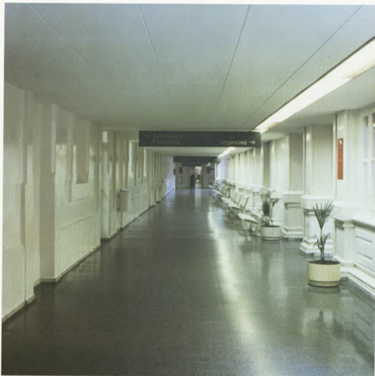
Barcelona. Hospital Clinic Pavimento de Vibrazo Basáltico Arqto. F. Correa y A. Milà
