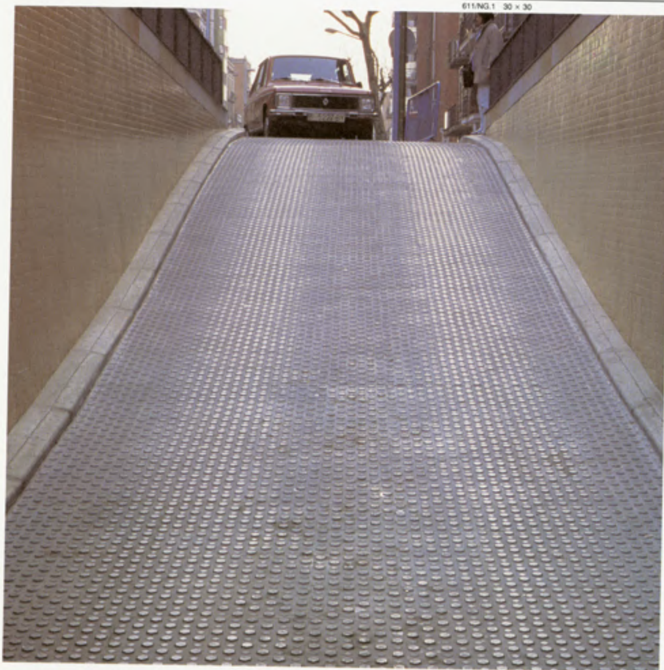
Rampa de aparcamiento (Barcelona). Pavimento antiderrapante para tránsito rodado con pendiente.
