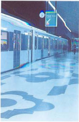
Pavimento de vibrado unicolor. Equipo técnico. Estación de metro. Línea 9. Duque de Pastrana. Madrid. 1978 One-tone "vibrado" paving. Technical development team. Metro station Duque de Pastrana. Line 9. Madrid. 1978
